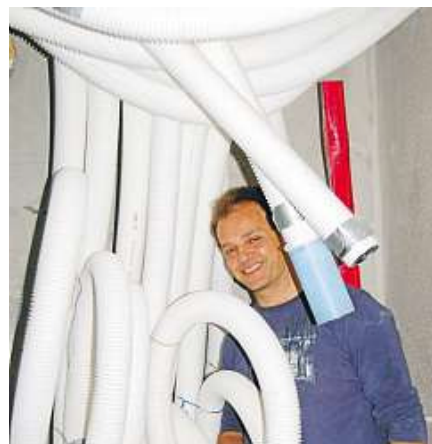
Jeder Raum hat eine eigene Luftzufuhr. An der Wärmepumpe kommt alles zusammen.
